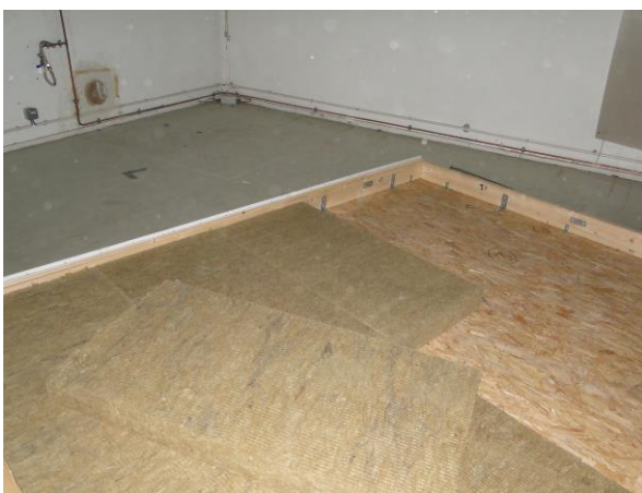
Mise en place de la laine de roche
