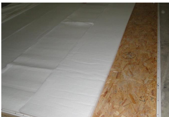
Mise en place de l'absorbant
