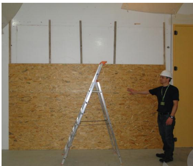
Mise en oeuvre de l'OSB sur les tasseaux
