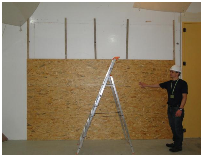
Mise en oeuvre de l'OSB sur les tasseaux
