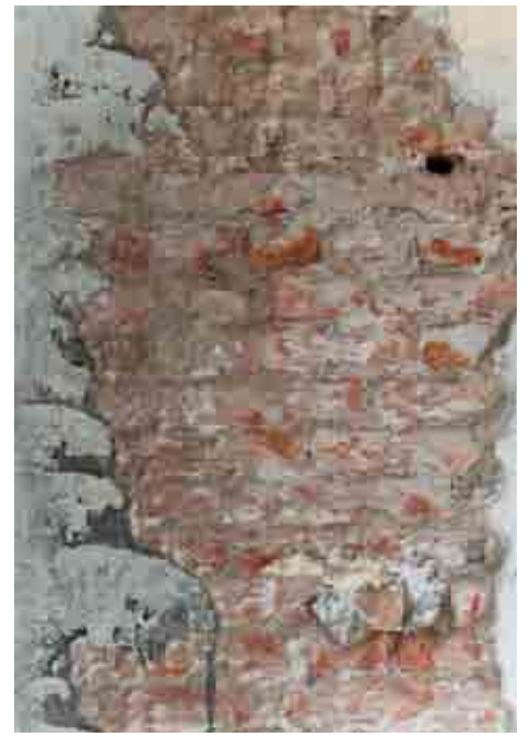
ADDG mur briques 1
