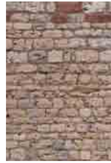
ADDG mur briques 2
